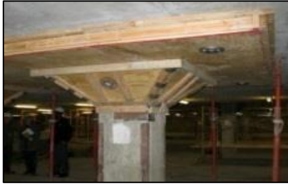
Fig : 14.8 : Flat Slab Construction
