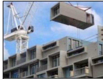
Fig : 14.7 : 3D Volumetric Modules
