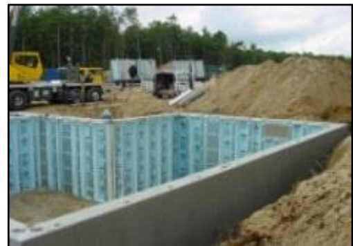
Fig : 14.9 : Precast Concrete Foundations
